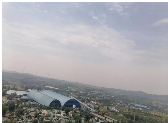
项目南侧现状
