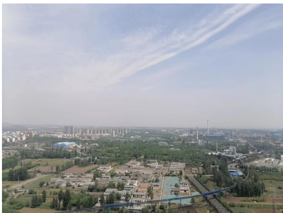
项目北侧现状
