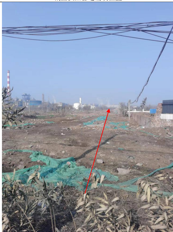
供热管道铺设位置
