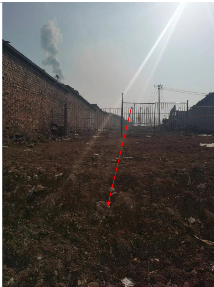
循环水及煤气管道铺设位置
